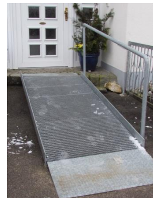
Links: durchlaufender zweiter Handlauf, der über die erste und die letzte Stufe hinausgeht.
