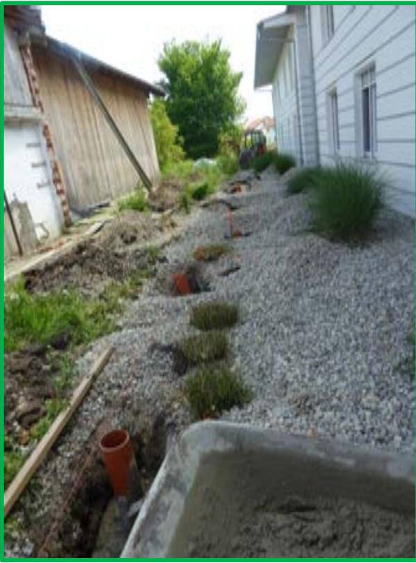
*In diese Rohre wurden die Pfeiler eingesetzt und durch das Auffüllen der Rohre mit Kies befestigt.*
